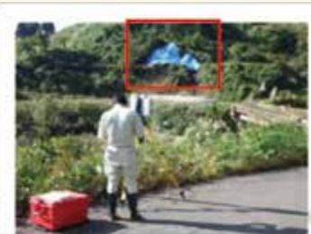
のり面復旧の計測 ※赤枠は3Dデータを取得する範囲
